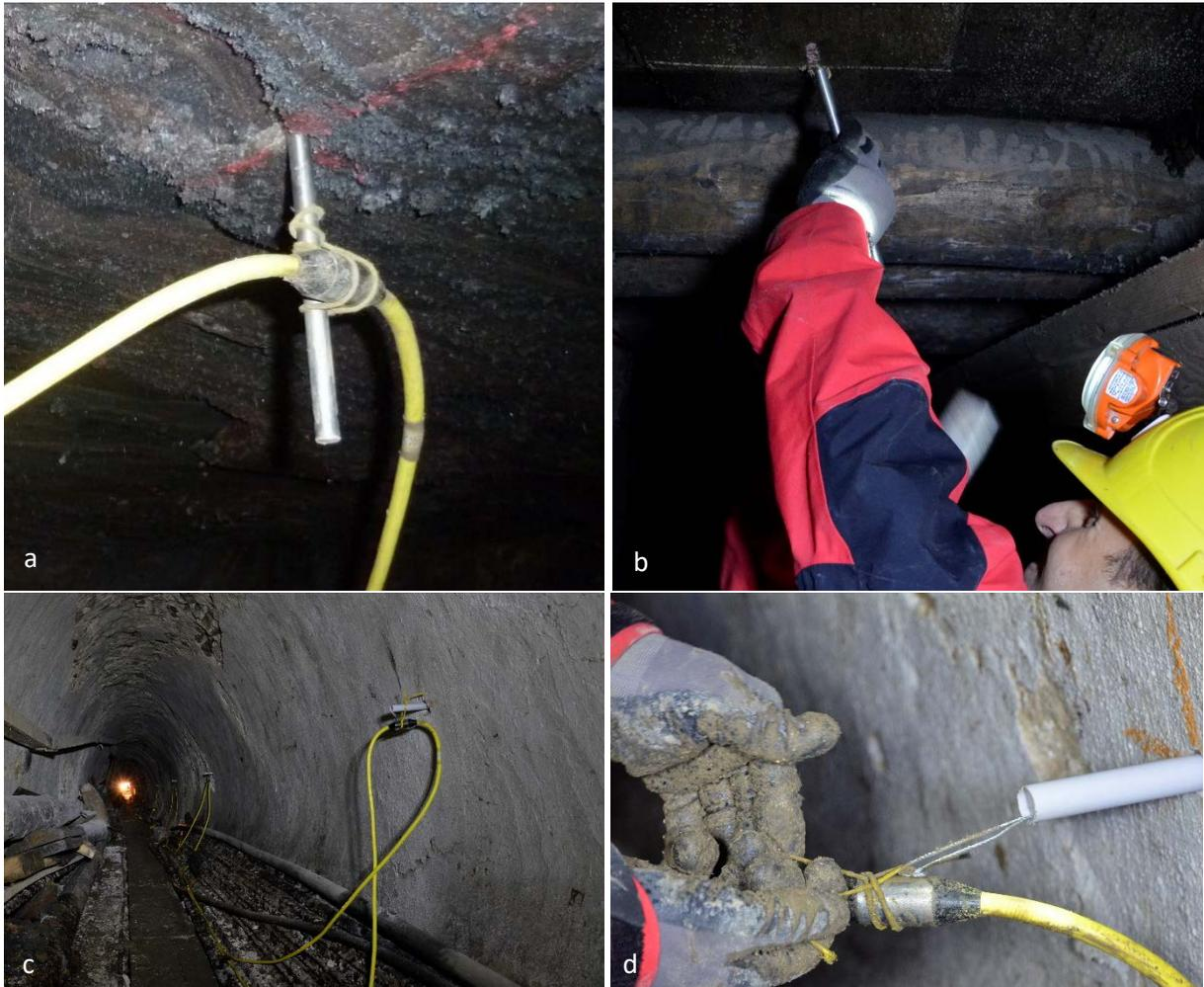
Abb. 55: Situationsfotos zur Elektrodeninstallation; a) Elektrode im frei zugänglichen Festgestein (Christina Stollen), b) Elektrode im Festgestein mit durchbohrter Holzschalung (Christina Stollen), c) Situationsfoto im Josef Stollen, d) Detail der Elektrodenanbindung mit Stahlseil
